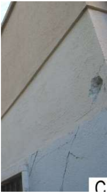
Fessurazione nodo d'angolo
